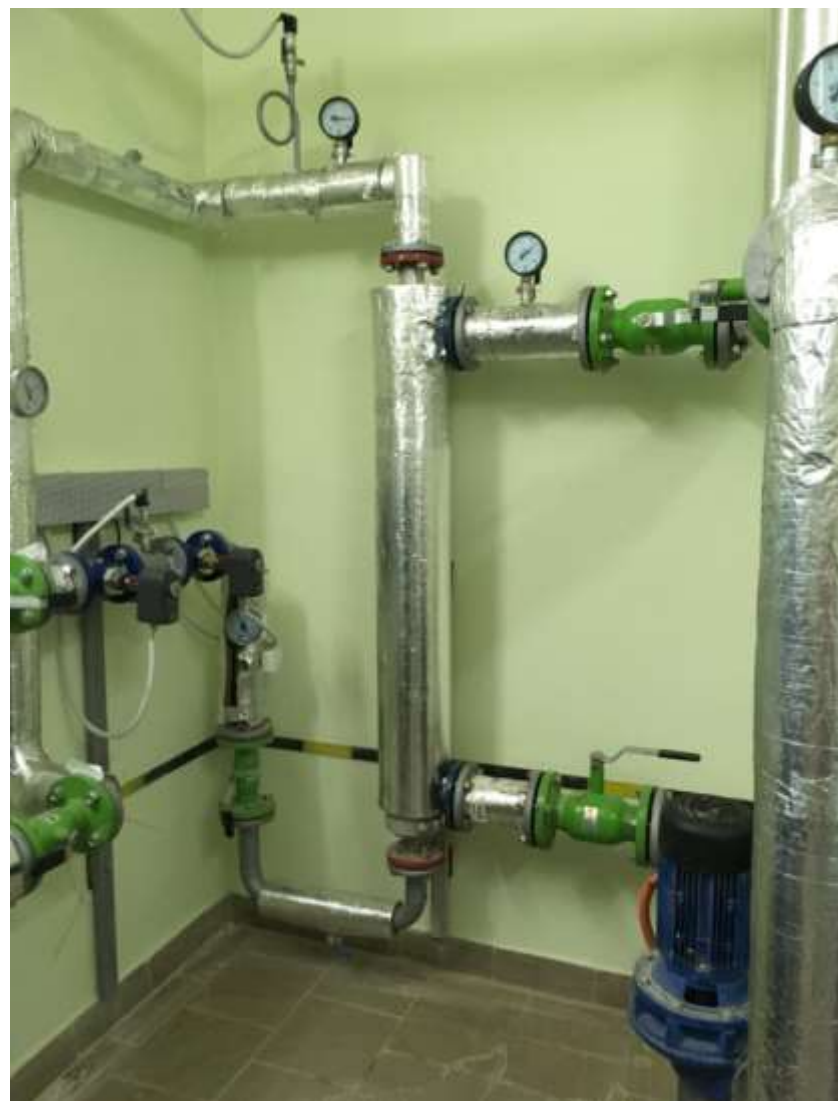
Рис. 2.3. Элементы схемы ИТП на базе кожухотрубных теплообменных аппаратов
