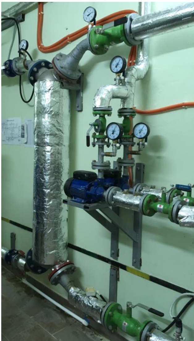
Рис. 2.3. Элементы схемы ИТП на базе кожухотрубных теплообменных аппаратов
