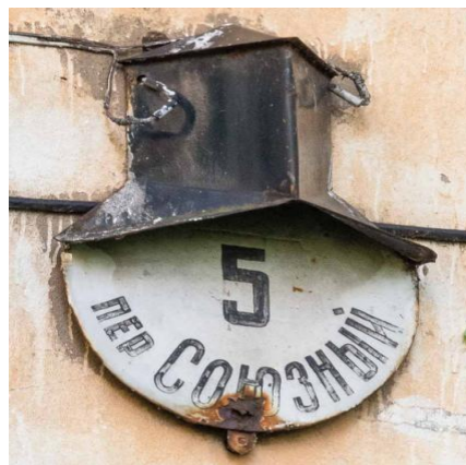
Тип 1.2. Аншлаг без выштамповки с глухим козырьком черного цвета. Белый фон, черные надписи. Моноширинный штифт без засечек
