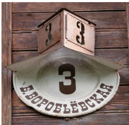
Тип 1.1. Аншлаг с круглой выштамповкой в центре и прорезанными цифрами в гранях козырька
